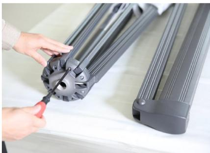
**1** Löse die Schrauben am oberen Strebenkranz (A).
